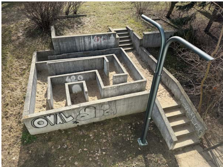
Halina Skibniewska i Alina Scholtzówna, betonowy labirynt dla dzieci na osiedlu Swoleżerów w Warszawie. Stan obecny, fot. Autor.
